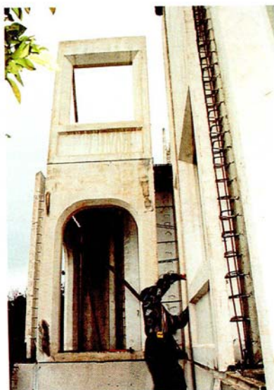
نمایش آزمون‌رندی اتصالات عمودی بین دو قطعه مجاور که در حد فاصل دو قطعه مجاور ستون ایجاد می‌کند.
