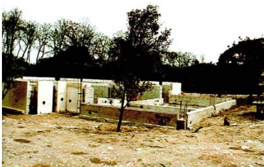
اجرای شلرده به صورت کفشک و کلاف روی آن
