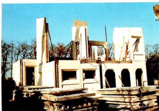
نصب قطعات طبقه اول روی طبقه همکف از نمای جنوبی ویلا
