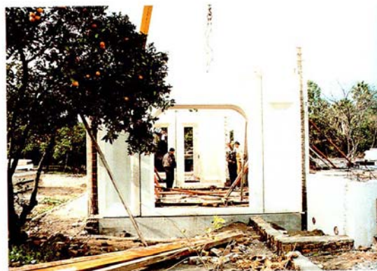
قطعات نمای پارکینگ و درب پارکینگ با استفاده از پانل قوسی به عرض 270cm (نمای شرقی)
