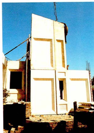
نصب قطعات نمای شیبدار طبقه اول در نمای غربی
